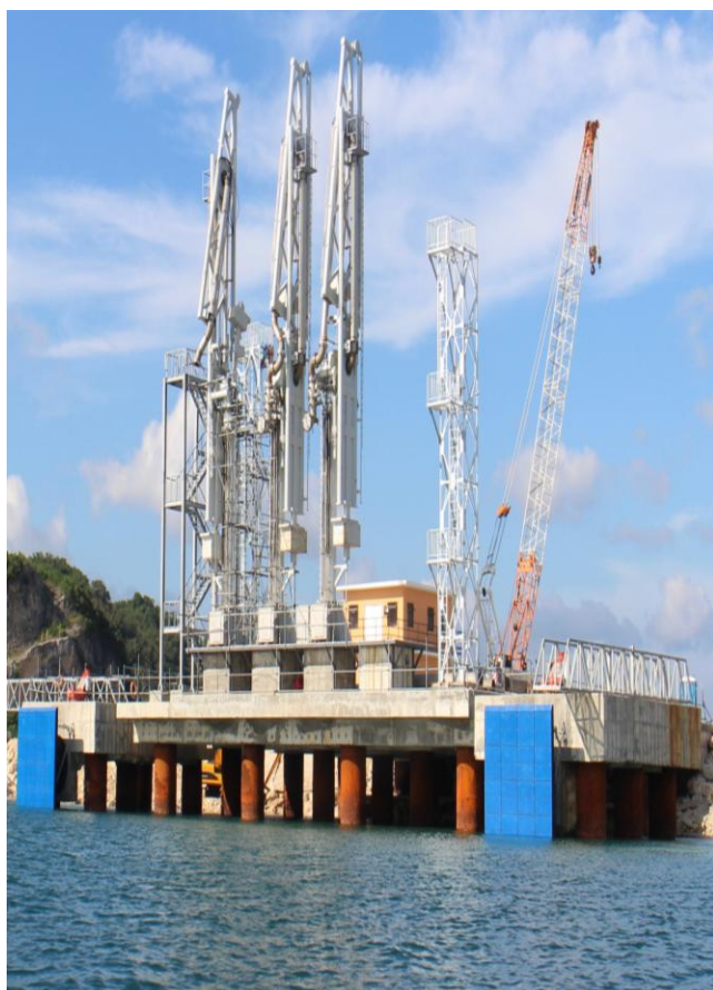
Erection of LNG Loading Arms
