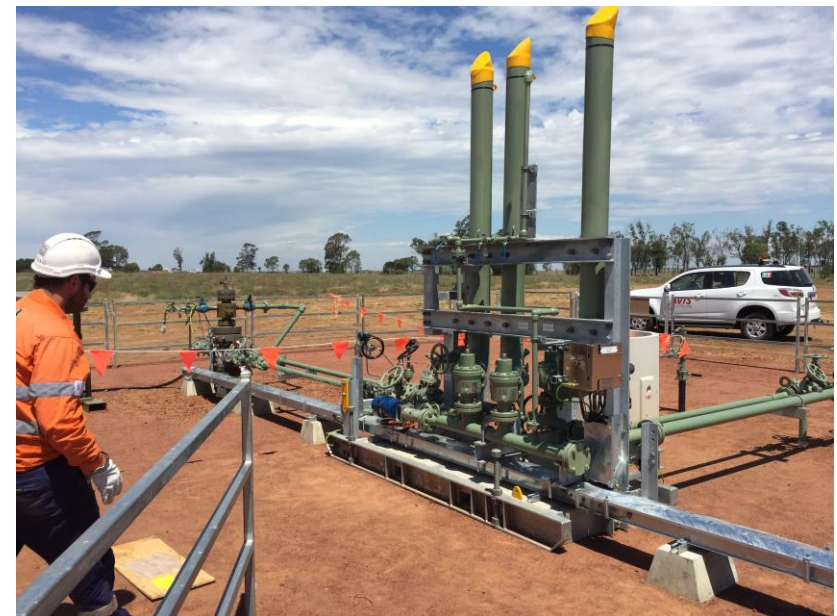
One Day Install (ODI) skid
