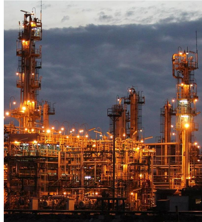
La Teja Refinery
