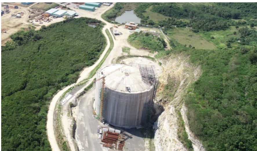
LNG Storage Tank
