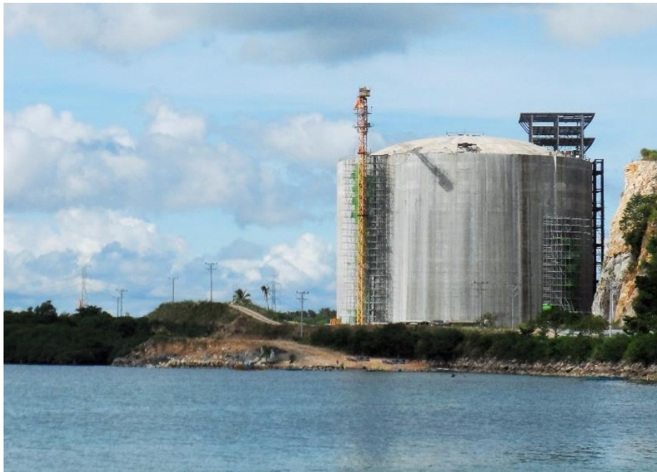
Pagbilao LNG Storage Tank
