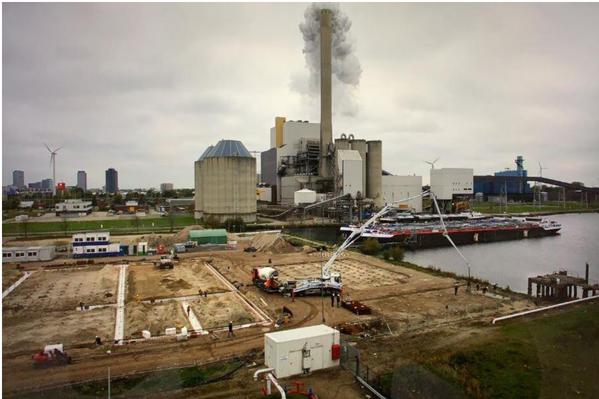
Concrete slab pour being undertaken by Ijbouw B.V.
