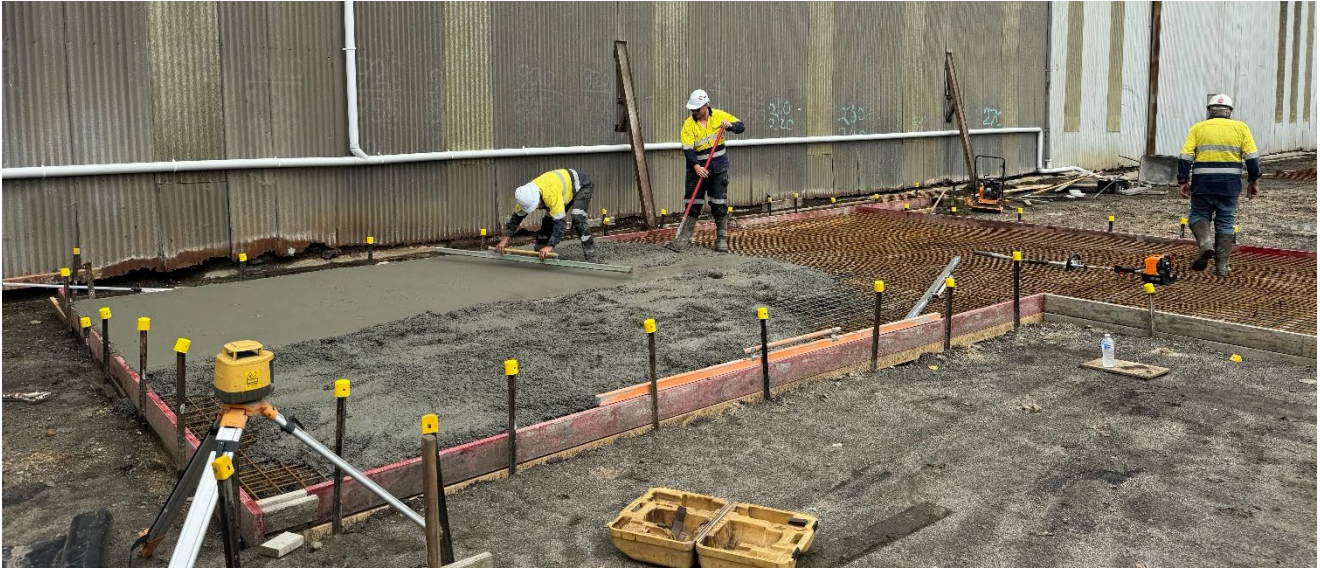
Figure: Gas footing concrete pour
