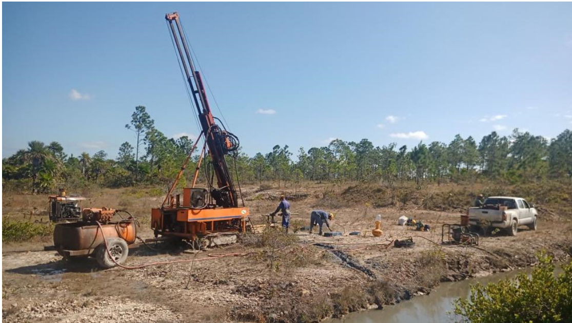
Drilling - El Pilar
