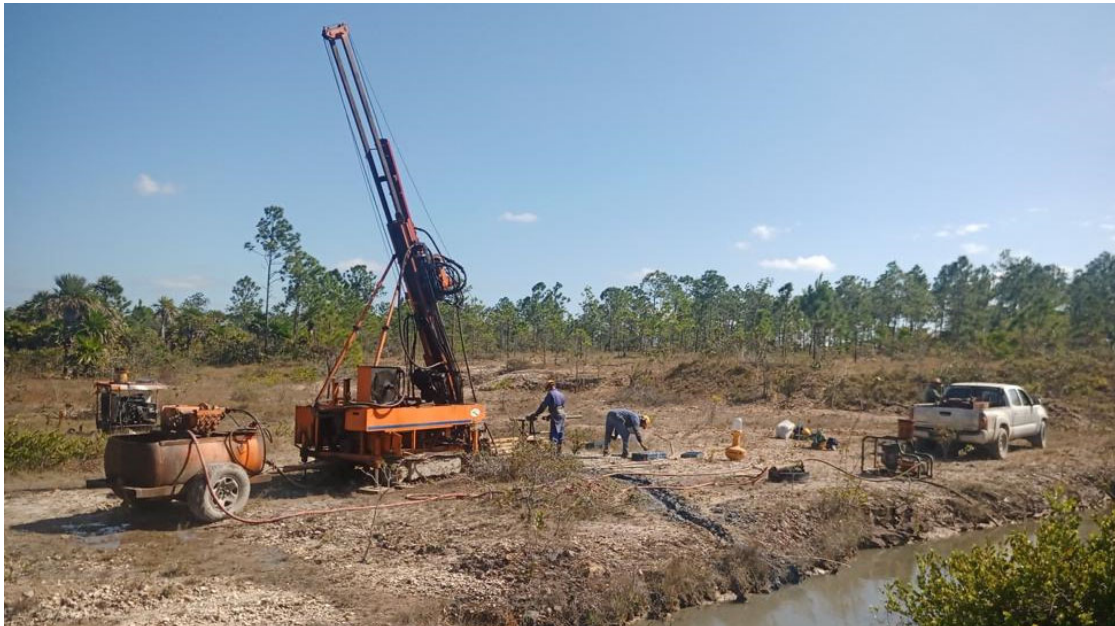
Drilling - El Pilar
