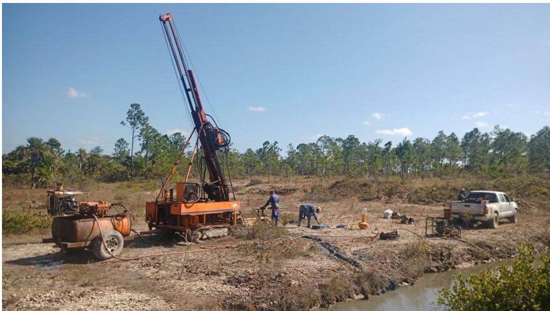
Drilling - El Pilar
