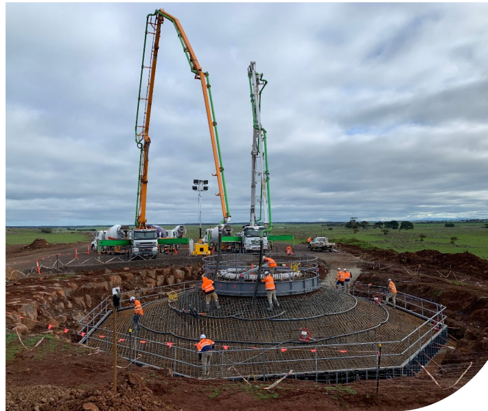
Wind turbine foundation pour
