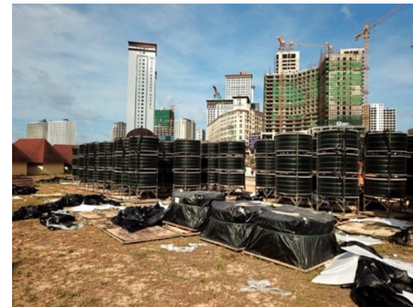
SUBRE modules on site
