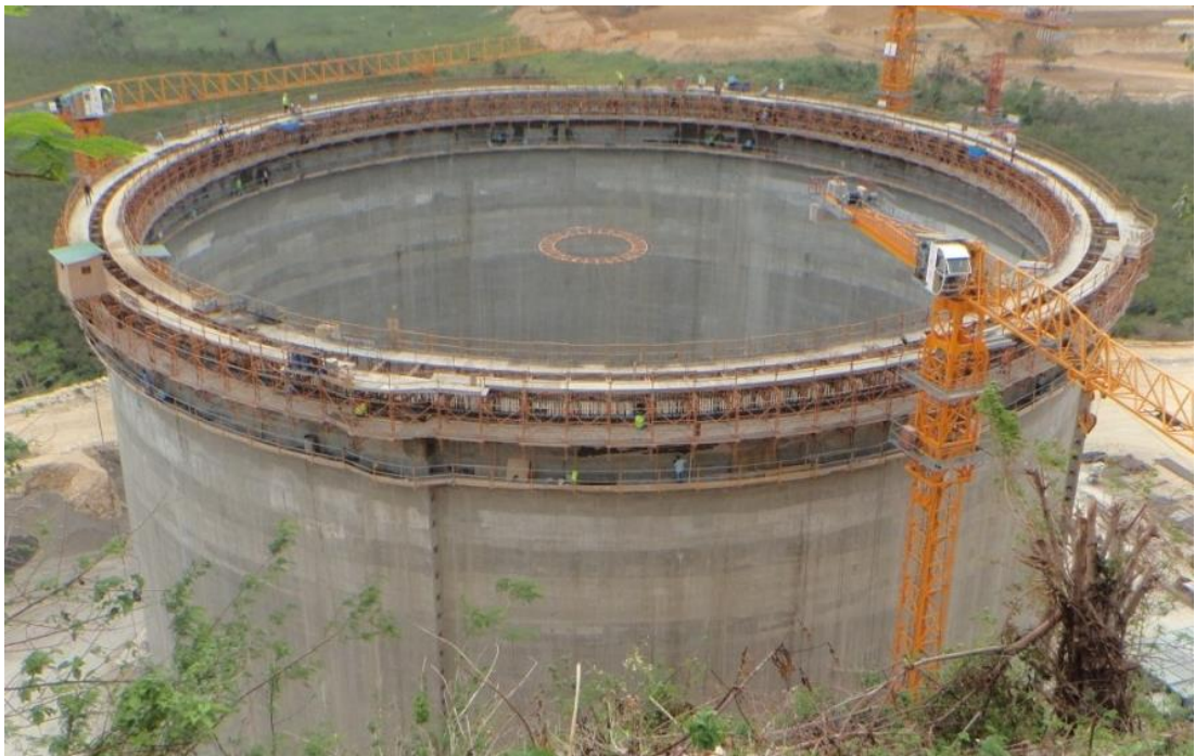
Construction of LNG Storage Tank
