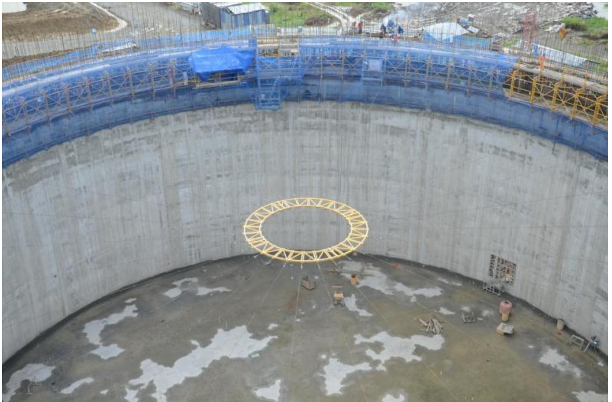
Construction of LNG Storage Tank
