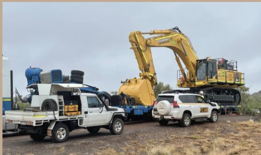
90 TON EXCAVATOR ON SITE
