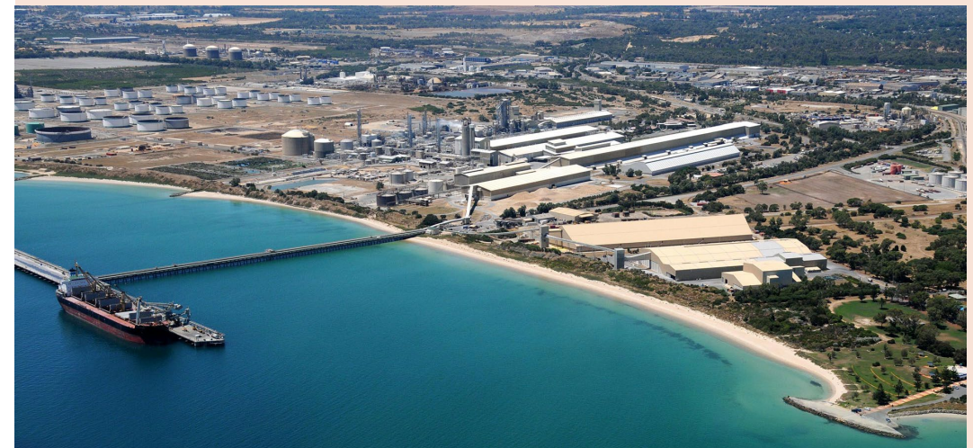
Kwinana Bulk Jetty, Fremantle Ports WA
