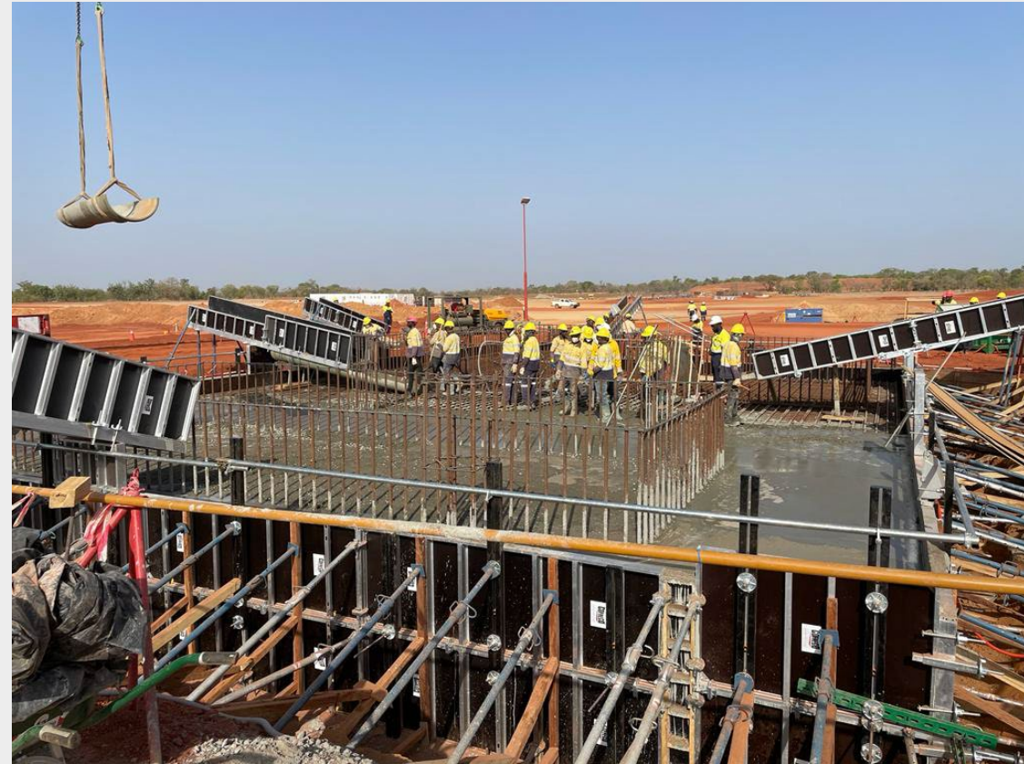
Pouring the ball mill raft slab on day shift
