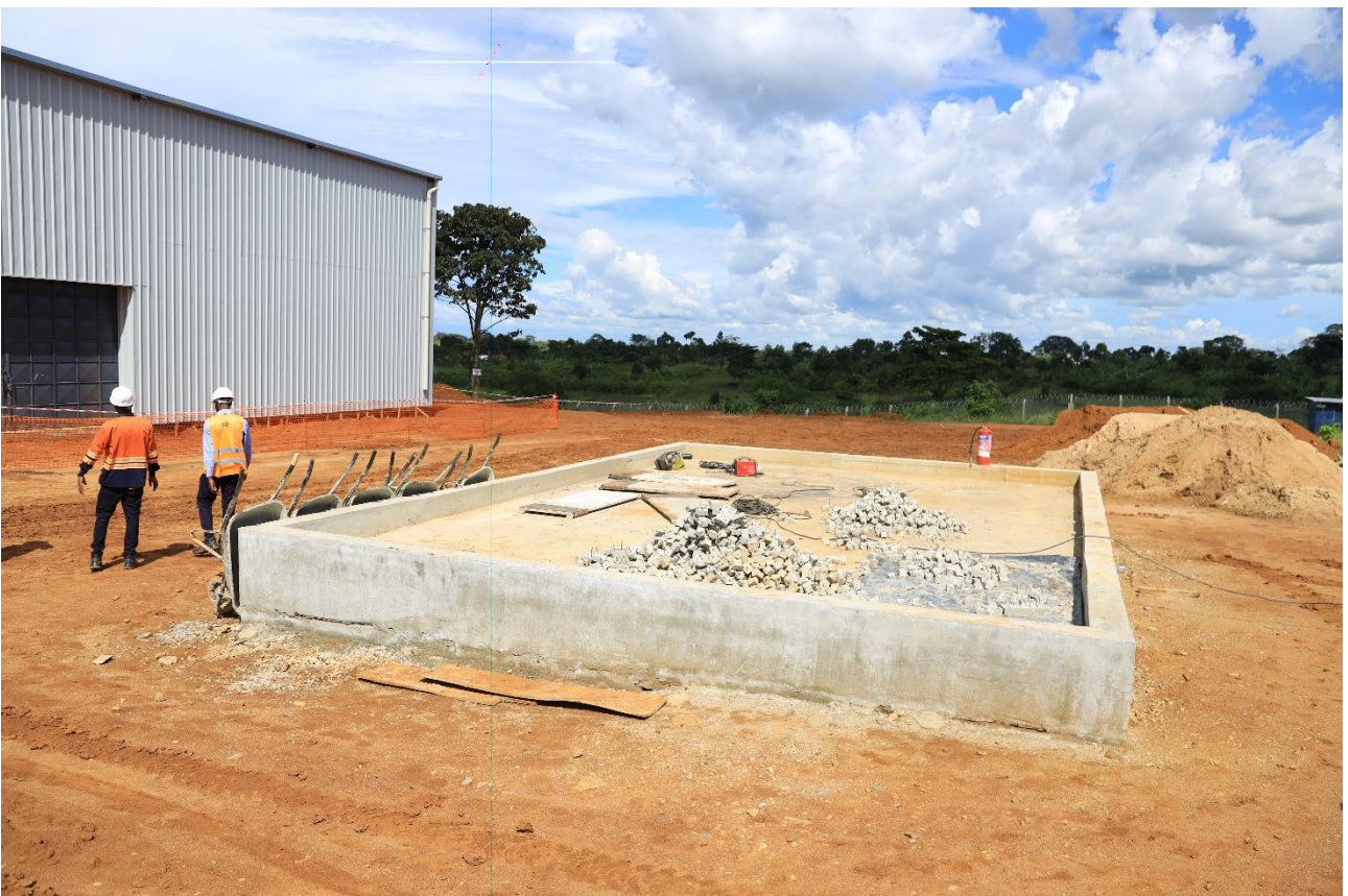
Figure 7: Makuutu stage 1 Demonstration Plant agglomerator pad.
