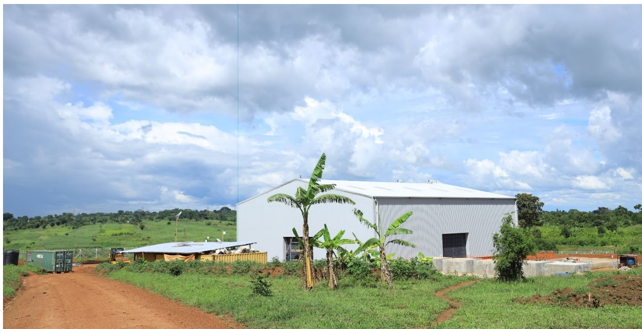
Figure 1: Makuutu Stage 1 Demonstration Plant.
