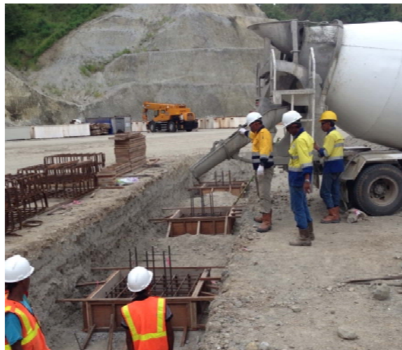
Image 6 – First concrete pour on the EW foundations
