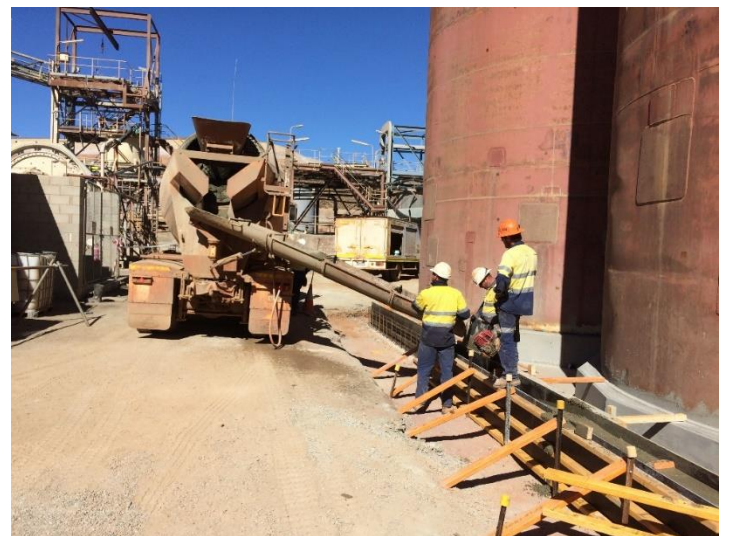
Photo 6: Concrete pour for new leach bunds
