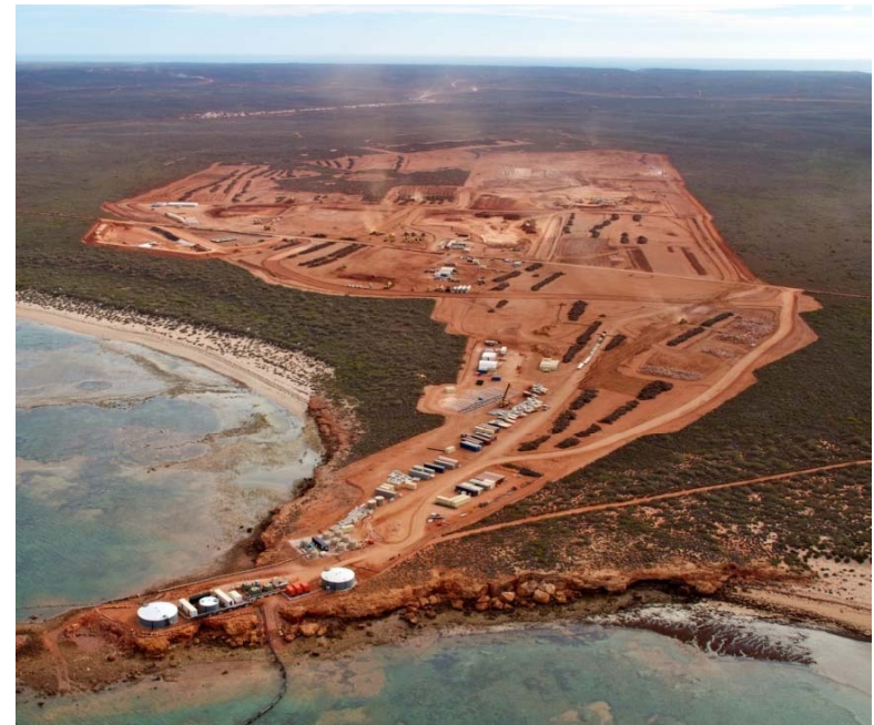
Aerial View of Gorgon LNG Plant site
