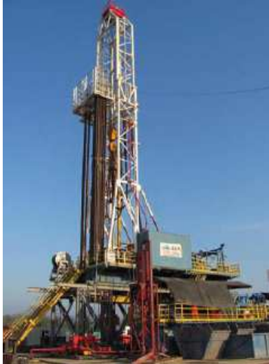
AD-1 Drill Rig
