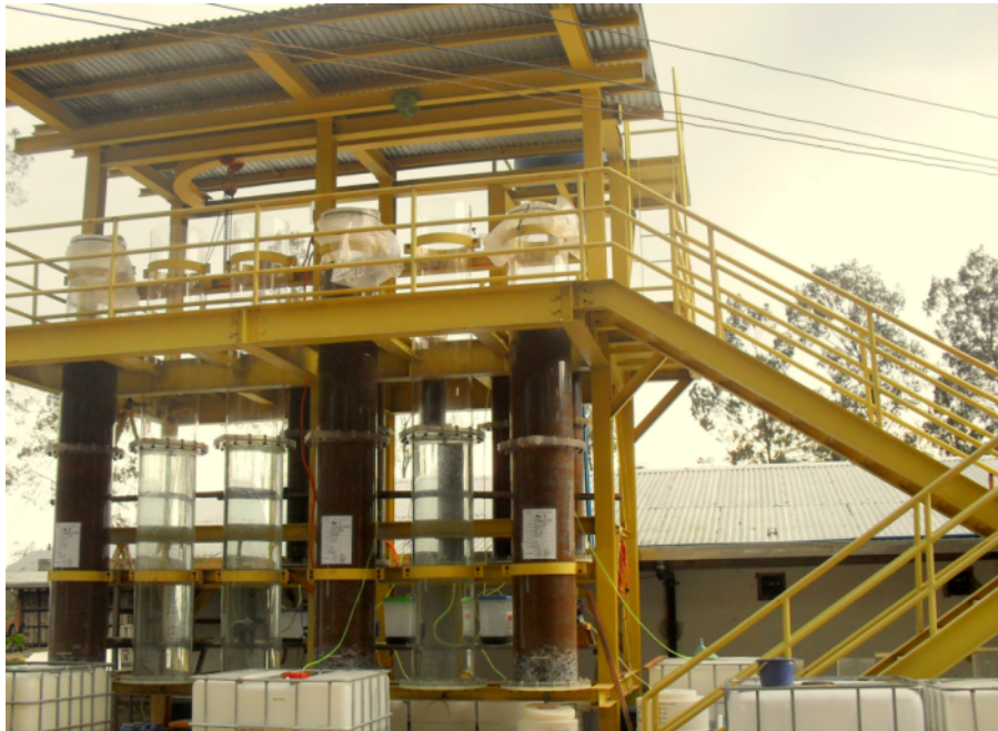
4m x 0.5m OD columns
