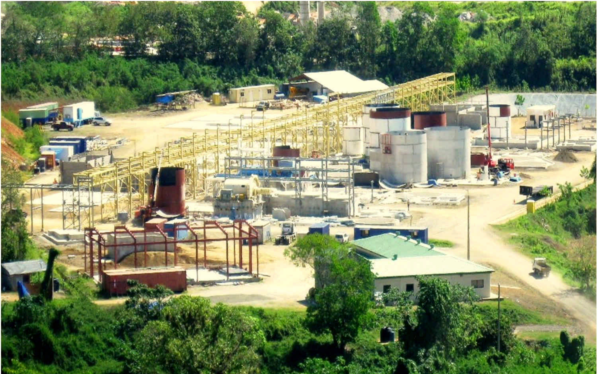
Las Lagunas Plant Site – Overview
