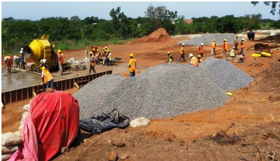
Concrete pour at the Assay Prep Lab
