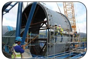
Sag Mill Shell Erection
