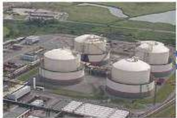
LNG Storage at Peakshaver
