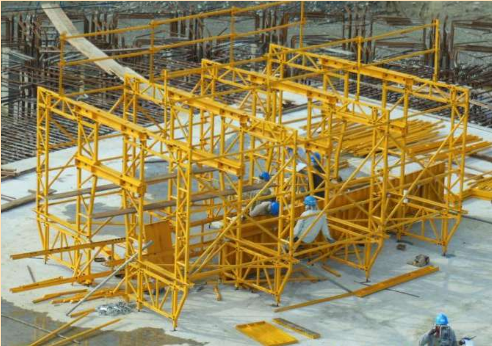
LNG Tank Construction Photo
