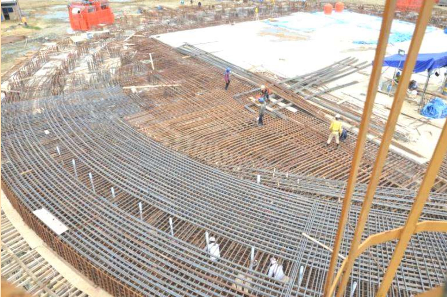
LNG Tank Construction Photo
