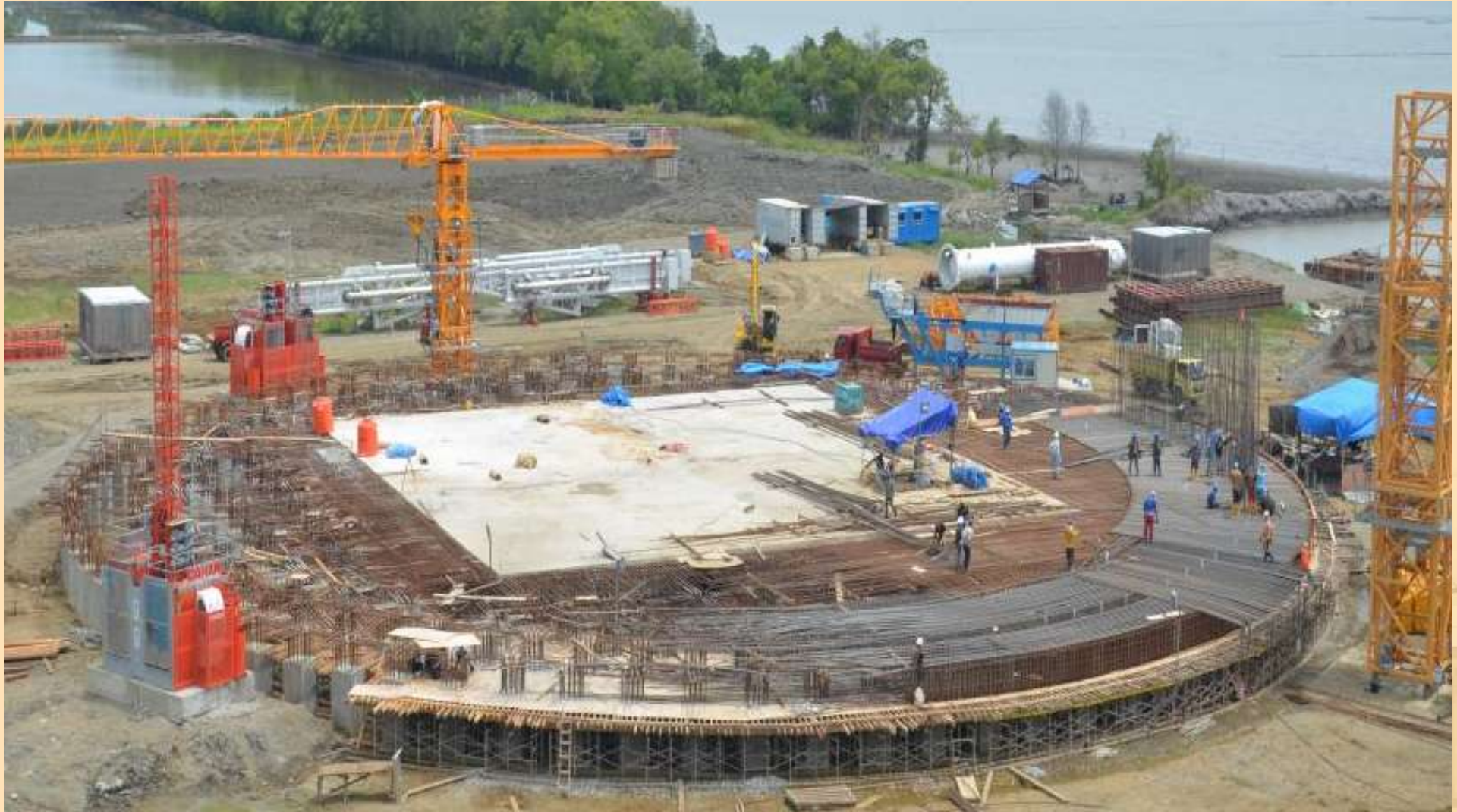
LNG Tank Construction Photo
