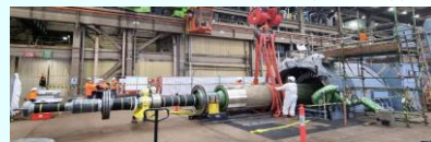
Loy Yang Unit 2 rotor refurbishment
