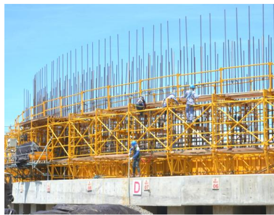
Construction of LNG Tank
