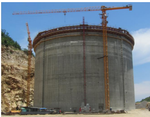
Pagbilao LNG Hub Site, Construction of LNG Tank
