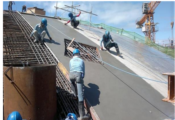
Construction of LNG Tank Roof
